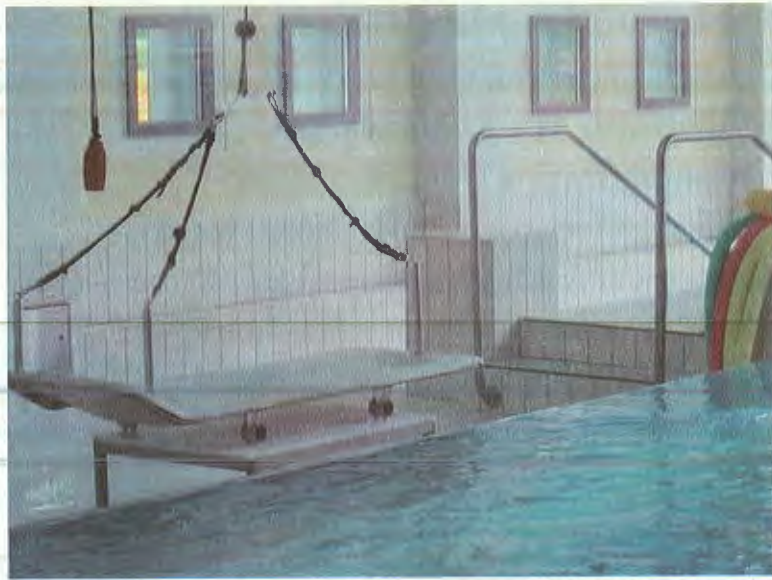
รูปภาพที่ 11.2 เครื่องยกแบบเตียงนอน ขึ้นลงสระน้ำ
