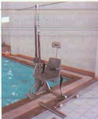
รูปภาพที่ 11.1 เก้าอี้สำหรับนำผู้ป่วยขึ้นลงสระน้ำ
