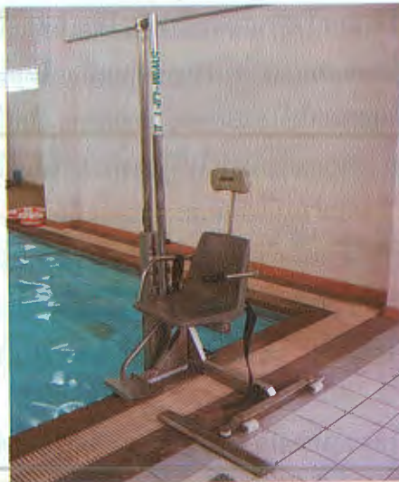
รูปภาพที่ 6.17 เก้าอี้เลื่อนลงและขึ้นจากสระน้ำ
