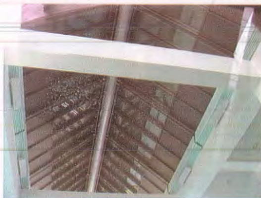
รูปภาพที่ 6.4 หลังคากระจกโปร่งใสและเปิดระบายอากาศได้
